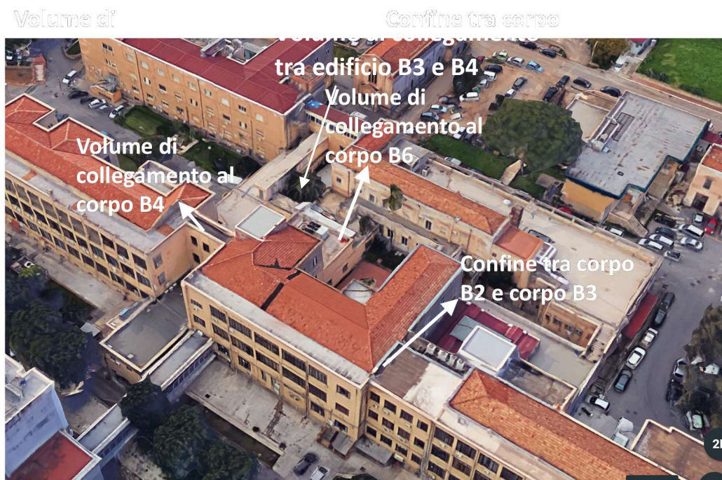
Fig.16. Vista dell'edificio B3 con particolare dei collegamenti agli edifici B2, B4, B6.
